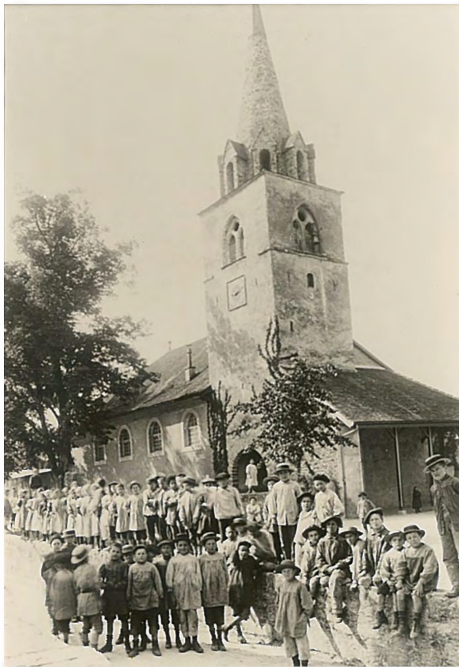
Les écoliers de La Tour-de-Peilz et leurs maîtres célèbrent les promotions. L'école est tout près, dans l'antique enceinte. Les trois étapes de la construction du clocher apparaissent très nettement : d'abord la tour de garde primitive surplombant une des portes de la ville, puis l'étage des cloches, magnifiquement ajouré et enfin la pyramide terminale en forme d'octogone, avec ses lucarnes typiques des clochers du Chablais.
