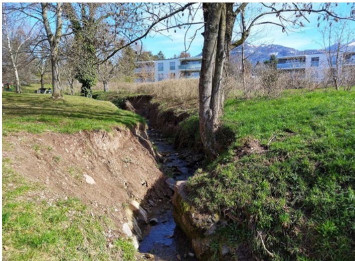
Vision générale – tronçon supérieur
